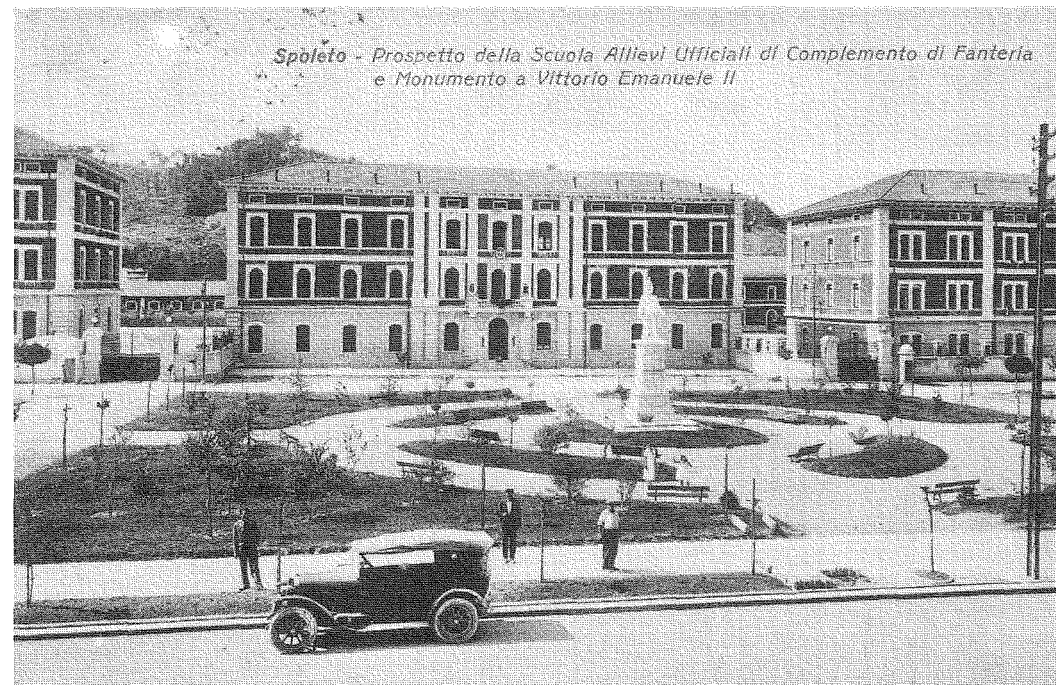
FIG. 17 - Prospetto della Scuola allievi ufficiali di complemento di fanteria e monumento a Vittorio Emanuele II.
