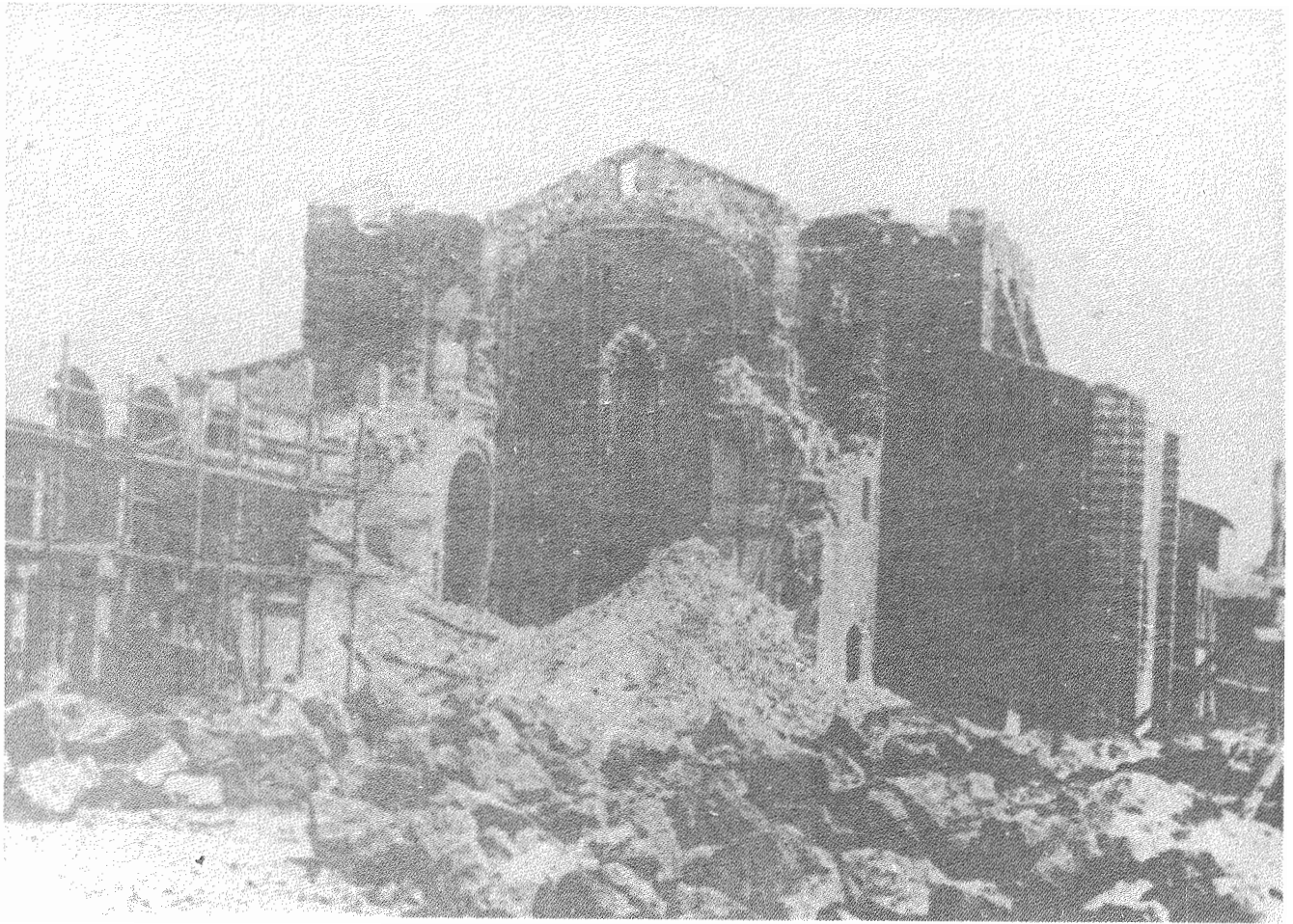
FIG. 6 - La chiesa di S. Domenico durante la demolizione per la costruzione dell'Accademia della G.I.L.
