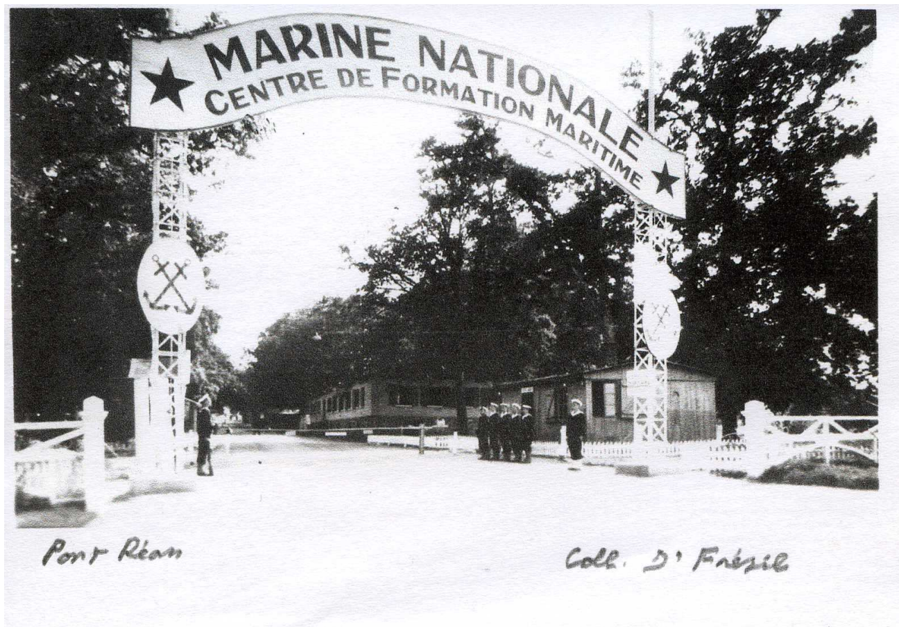
Fig. 3: CFM di Pont Réan - sulla destra baracca tedesca in legno (4) utilizzata come posto di guardia ed al centro, sullo sfondo, una delle baracche tedesche in muratura (5) per 100 persone
