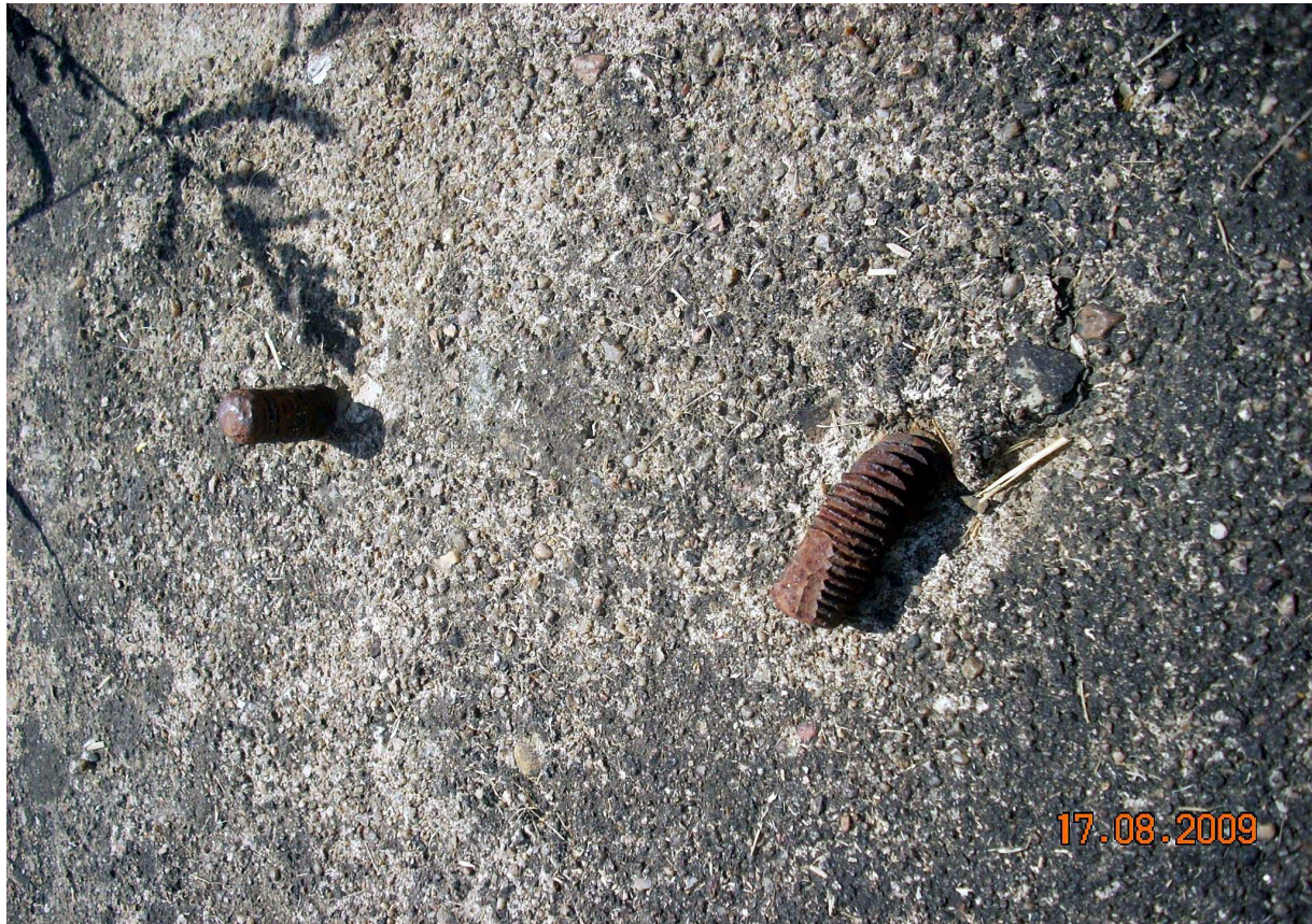
Fig. 11: base d'antenna (26) – punti di appoggio del mast dell'antenna
