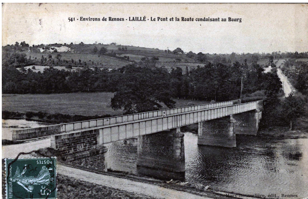
Fig. 13: ponte de La halte di Laillé chiamato ironicamente Ponte di Mosca
