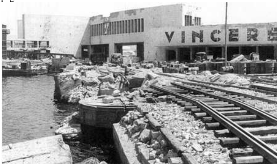
La stazione marittima di Messina ed il tratto di banchina antistante visibilmente danneggiata. (IWM, per gentile concessione di L. Bovi)
