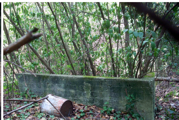
Fig. 14: base (14) per cavo di ancoraggio d'antenna (1 metro x 1 metro) Fig. 15: cisterna (3 metri x 4 metri)
