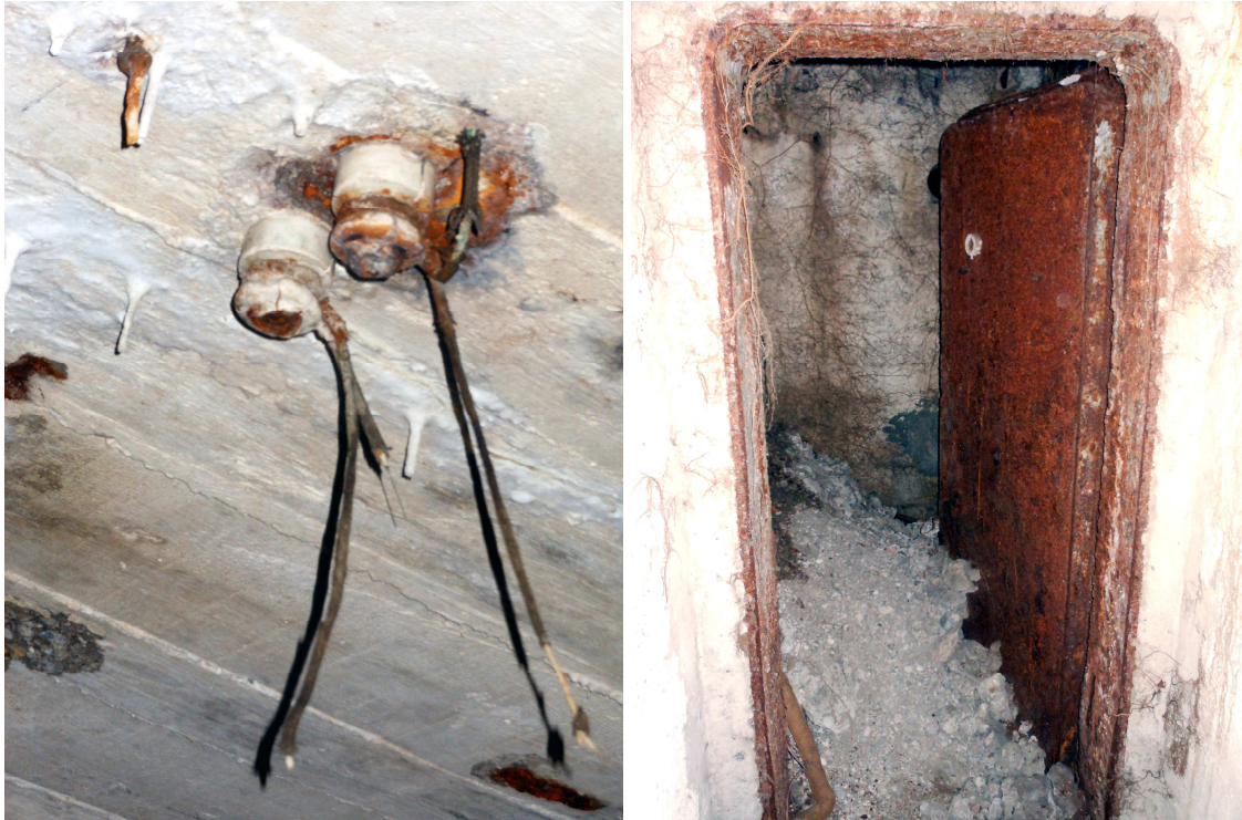
Fig. 13: isolatori elettrici con stalattiti Fig. 14: Raum 7 - porta blindata Conforti
