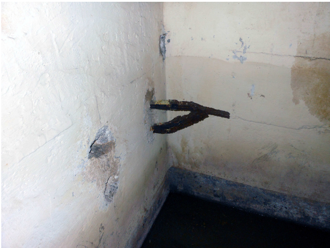
Fig. 27: vano 3 – sostegno arrugginito di una mensola
