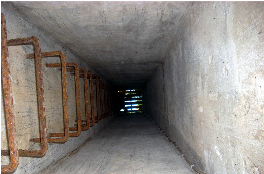
Fig. 30 : pozzo di uscita del bunker
