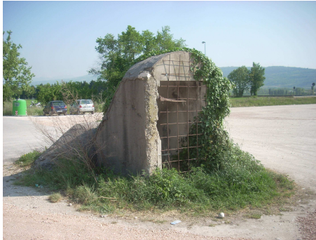
Fig. 5 : secondo primo ingresso del bunker
