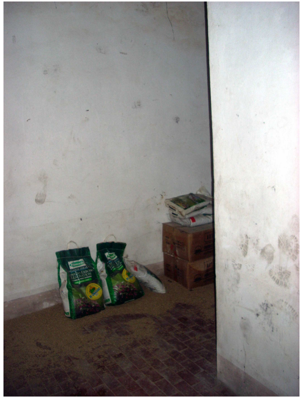
Fig. 9: accesso al corpo centrale del bunker
