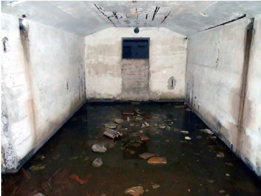
Fig. 23: vano 4, Raum 2 – sulla sinistra ingresso al vano 3, al centro ingresso al Raum 1 parzialmente murato, sulla destra, non visibile, ingresso / uscita verso la stazione di Verona Porta Nuova
