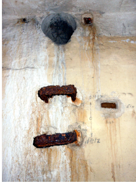
Fig. 29: vano 1 – dettagli del quadro elettrico
