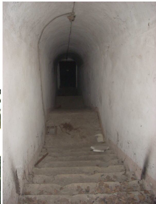
Fig. 5: discesa a gradini del bunker (4)
