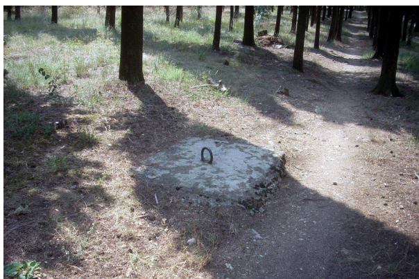
Fig. 14: base (14) per cavo di ancoraggio d'antenna (1 metro x 1 metro) Fig. 15: cisterna (3 metri x 4 metri)
