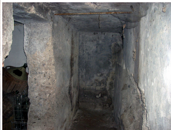
Fig. 20: rifugio (f) - corridoio e camera parallela
