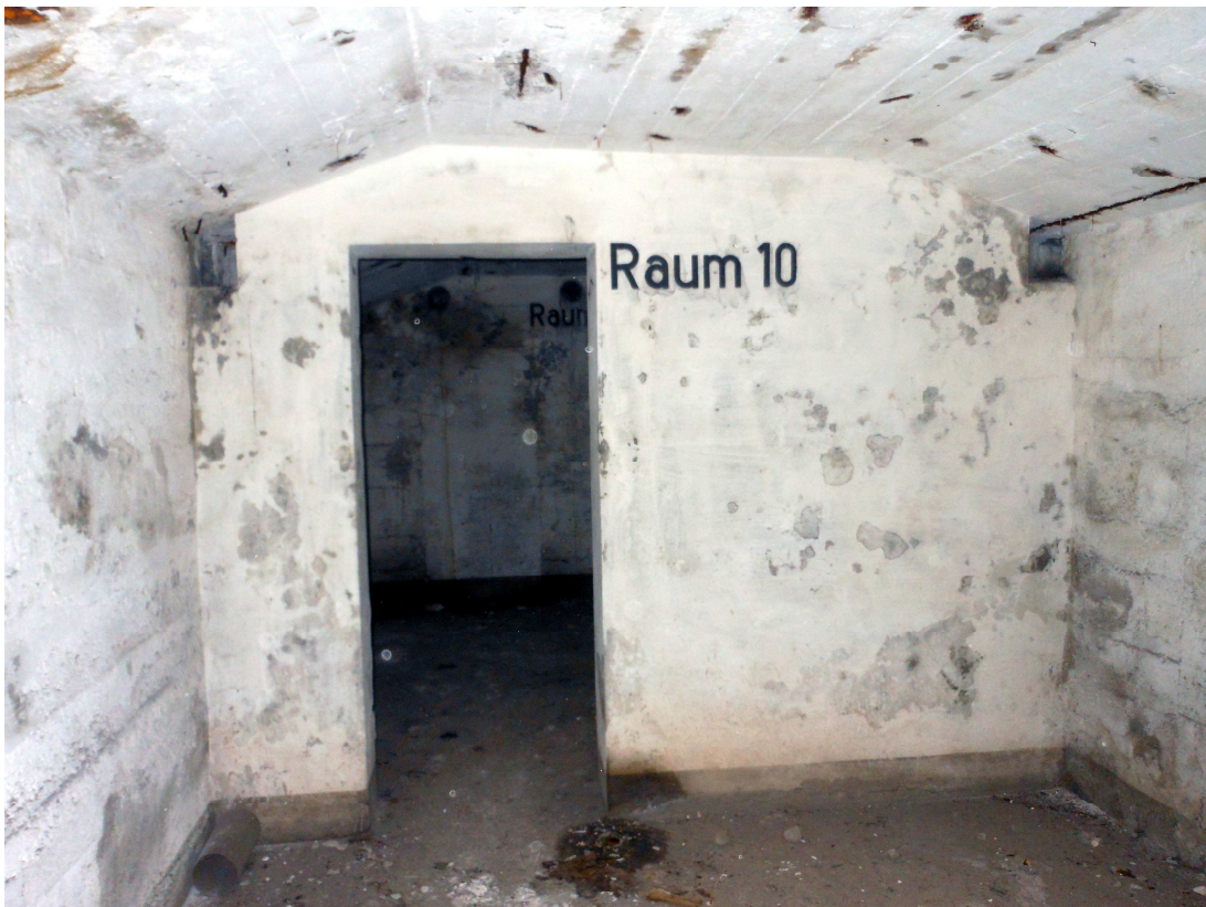
Fig. 9: Raum 10 – muro divisorio ed ingresso al Raum 9
