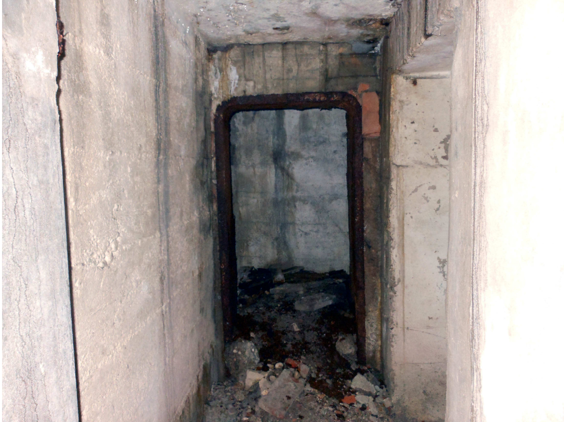
Fig. 26: vano 3 - ingresso / uscita verso il vano 9 ed il centro città - dettagli
