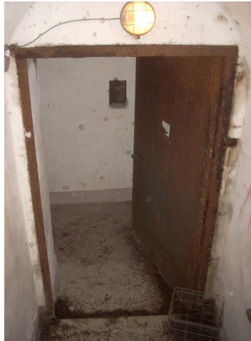
Fig. 27 : porta metallica di d'ingresso
