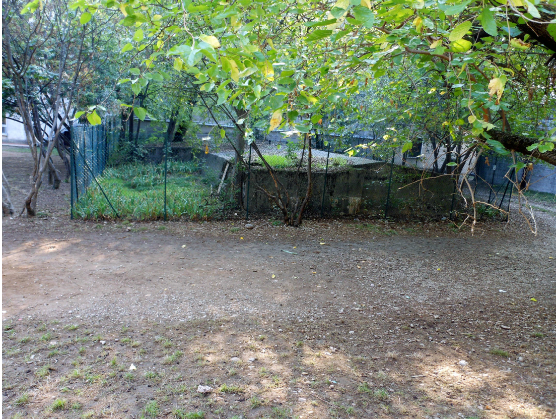
Fig. 2: Bunker della WVD Italien – visione d’insieme
