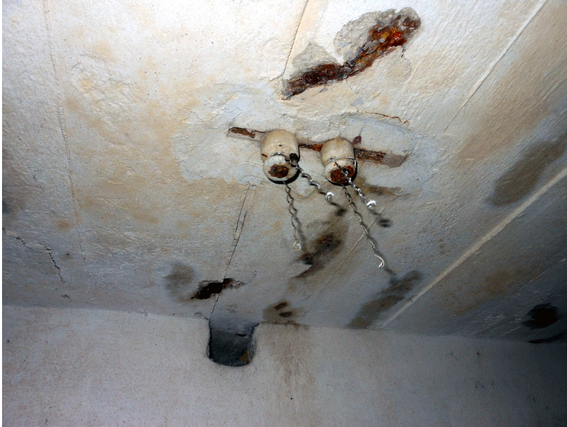
Fig. 21: Raum 5 – isolatori per cavi elettrici
