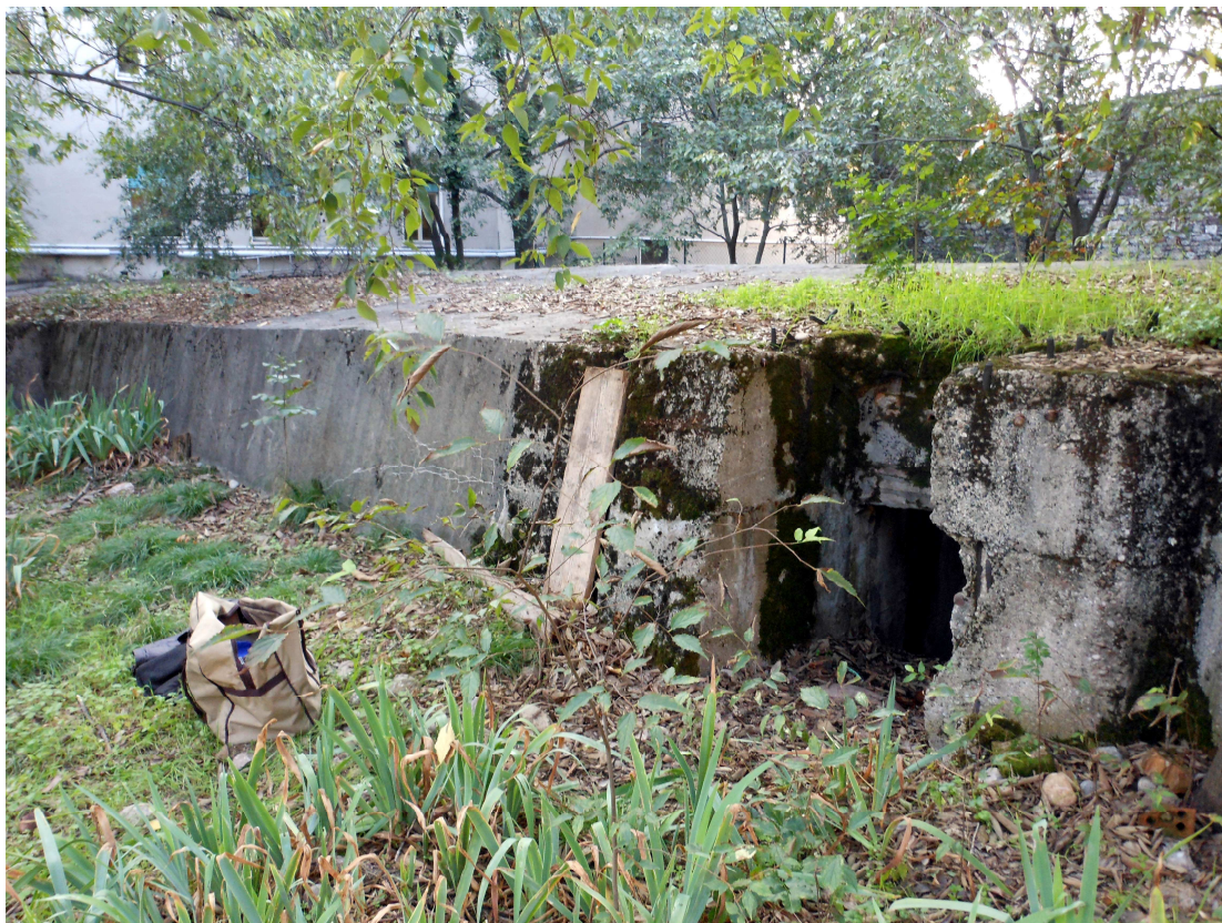
Fig. 6: ingresso / uscita parzialmente ostruito del bunker, sulla sinistra uno dei due incavi probabilmente paraschegge
