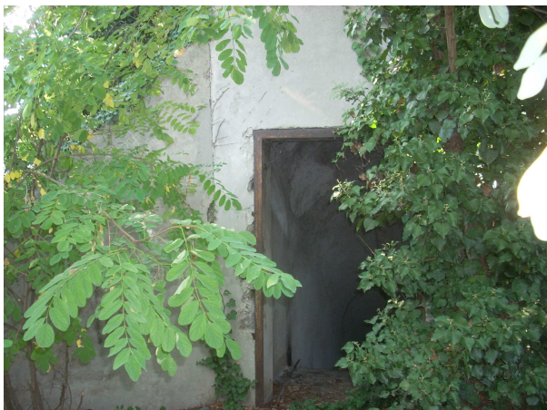
Fig. 4: ingresso del bunker (4)
