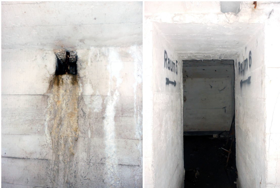
Fig. 18: Raum 7 – foro d'aerazione Fig. 19: Raum 7 – ingresso ai Raum 5, 6
