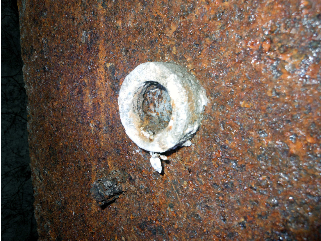
Fig. 15: porta blindata Conforti – dettagli del possibile foro di osservazione
