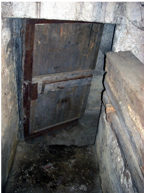
Fig. 19: rifugio (f) - porta d'ingresso
