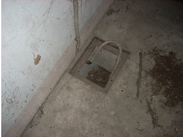
Fig. 6: pozzetto sul primo pianerottolo
