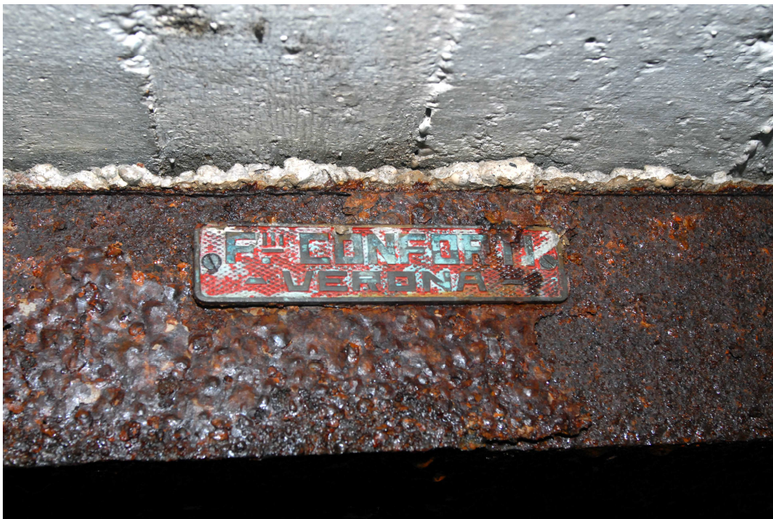
Fig. 16: porta blindata Conforti – dettagli della targhetta di identificazione
