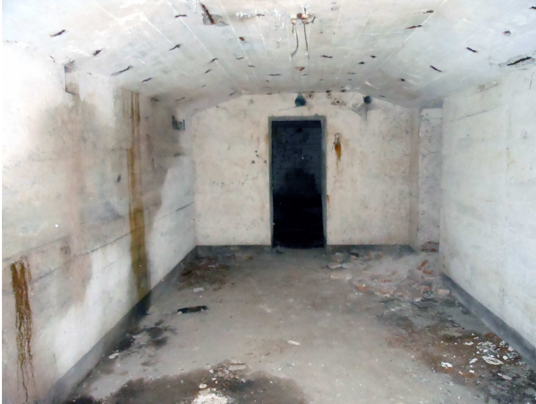
Fig. 12: interno del Raum 8 – a destra ingresso al Raum 8, al centro ingresso al Raum 7, sul soffitto due isolatori elettrici
