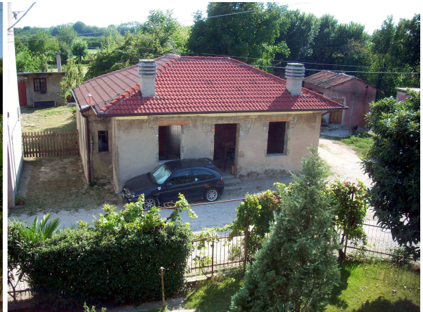
Fig. 18: abitazione degli ufficiali della batteria
