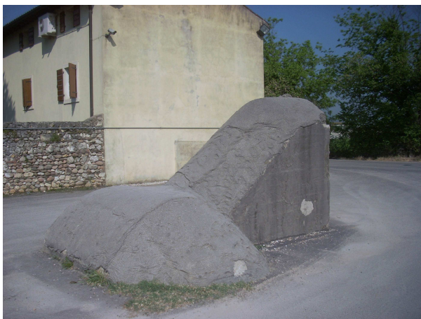
Fig. 3 : primo ingresso del bunker,
