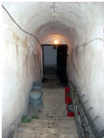
Fig. 26 : discesa a gradini del bunker
