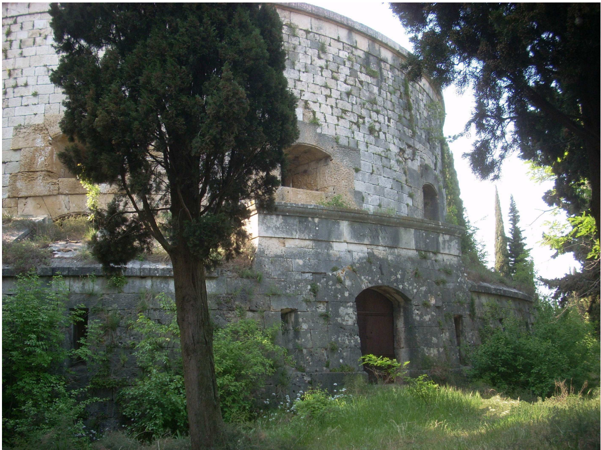
Fig. 8 : Torre 1 – periodo austro-ungarico
