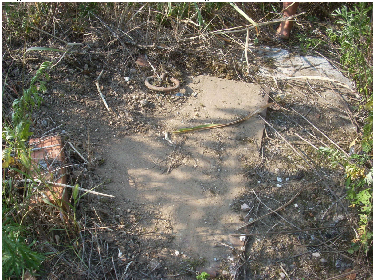
Fig. 10: tombino originale di chiusura del pozzo di uscita del bunker
