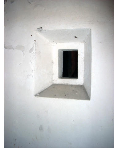
Fig. 28 : feritoia di sorveglianza
