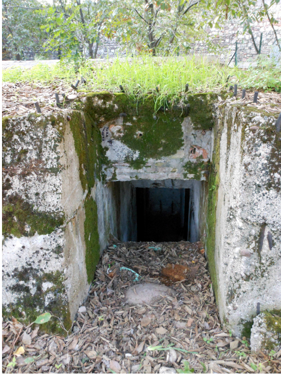
Fig. 7: ingresso / uscita – con tondini metallici d'armatura sporgenti
