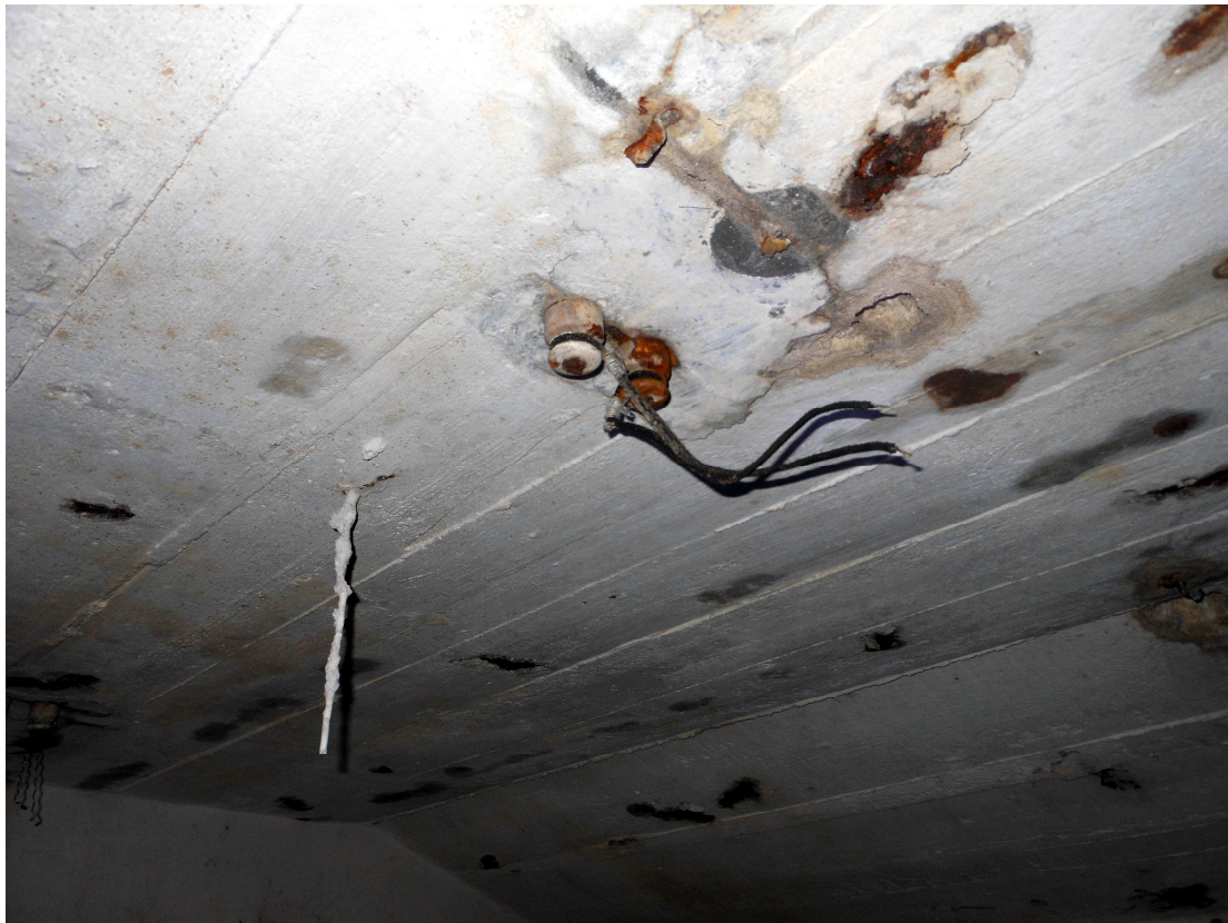
Fig. 20: Raum 6 – isolatore per cavo elettrico con impronta di portalampada e stalagmite
