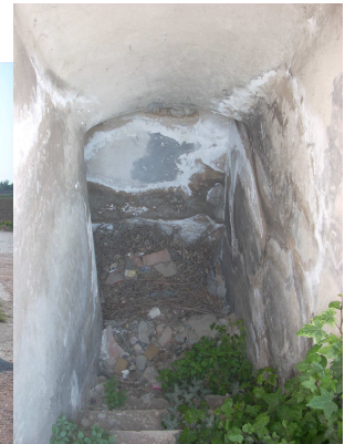
Fig. 7 : scala discendente e pianerottolo
