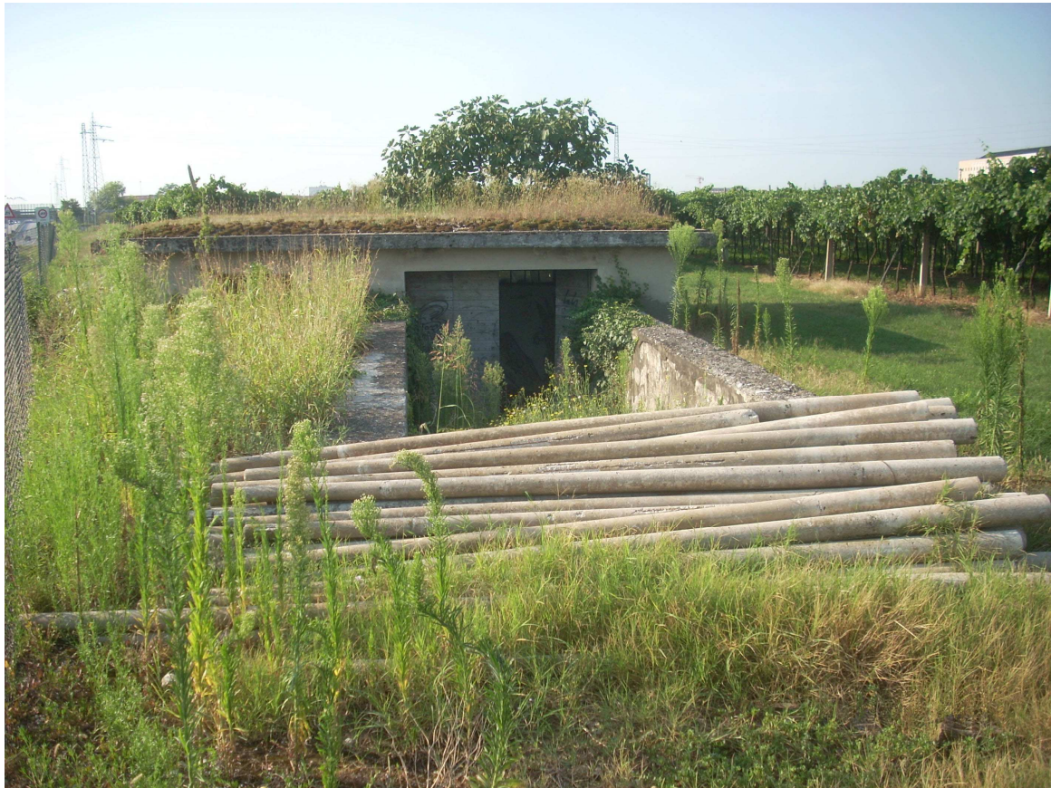
Fig. 14: bunker (6) lungo la Tangenziale Est – ingresso con scivolo e muri di protezione Costruzioni Militari nelle Aree del Pestrino e del Lazzaretto, a Sud di Verona La Fig. 15 indica le posizioni dei bunkers e costruzioni nelle aree del Pestrino e del Lazzaretto.
