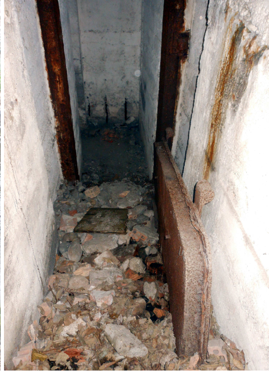
Fig. 8: scala di discesa - sulla destra porta blindata Conforti
