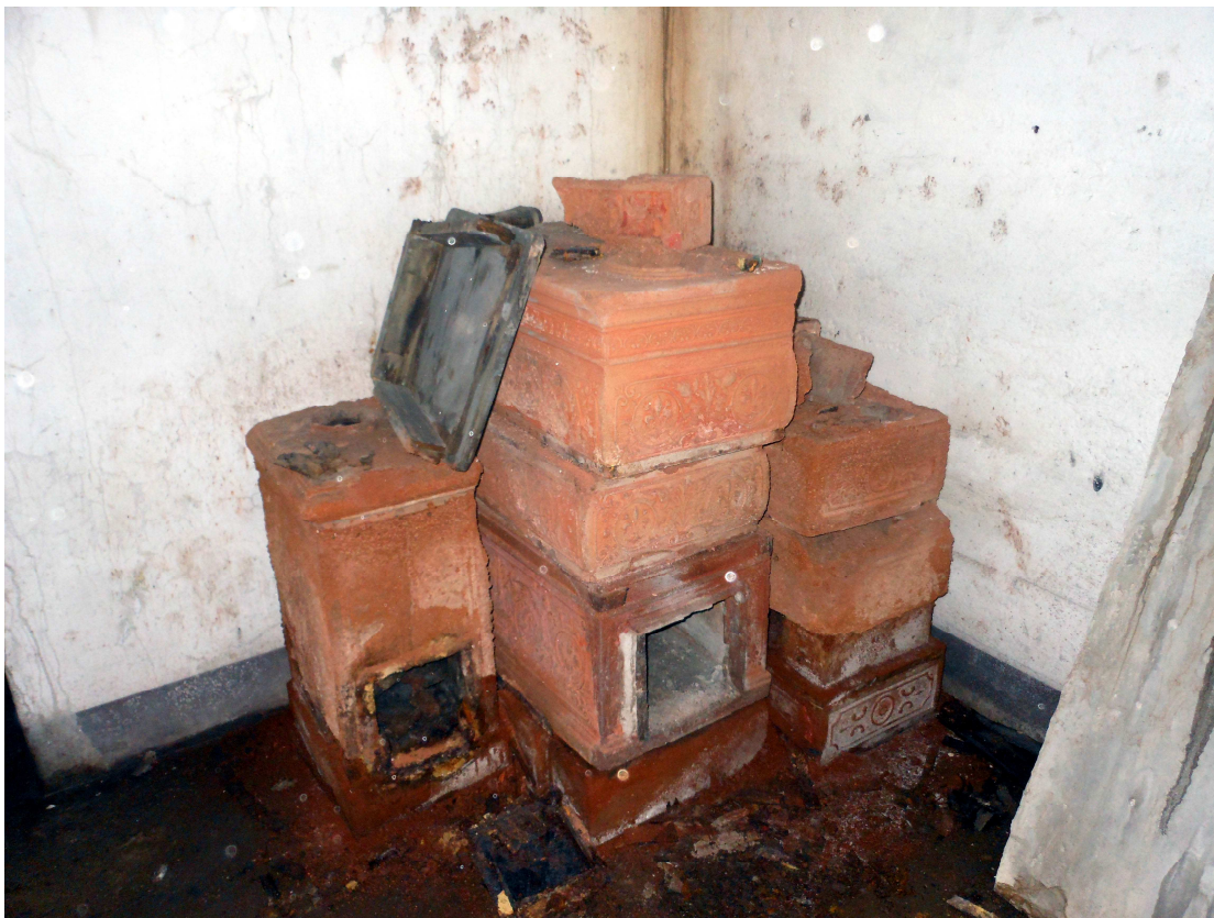
Fig. 22: Raum 5 - stufe per il riscaldamento del bunker
