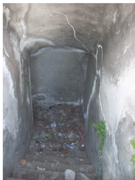
Fig. 4 : primo ingresso, scala
