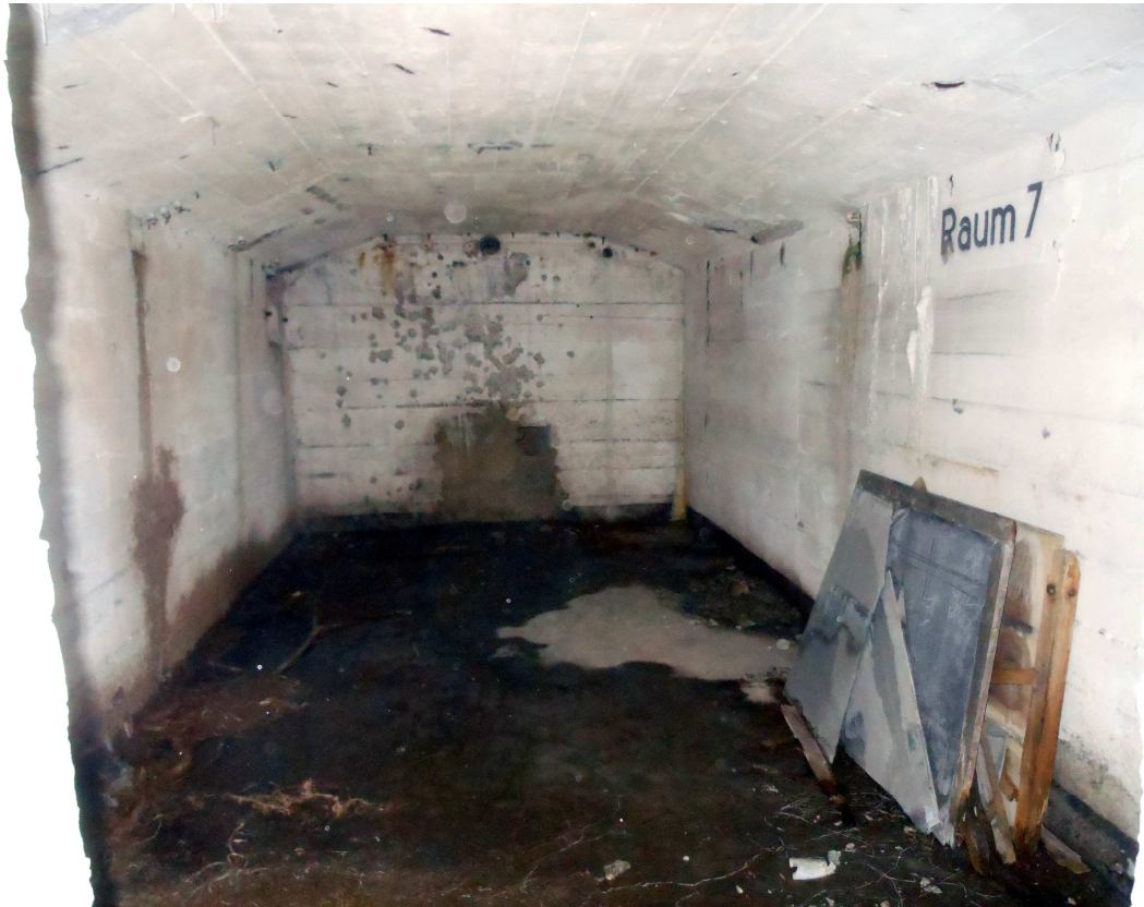
Fig. 17: vano 5, Raum 7 – al centro ingresso ribassato e murato, sul muro di fondo fori probabilmente dovuti a impatto di proiettili, non visibile, sulla destra, l'ingresso ai Raum 5, 6
