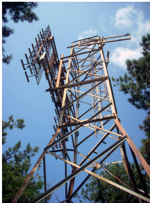
Fig. 22: dettagli del radar - dipoli
