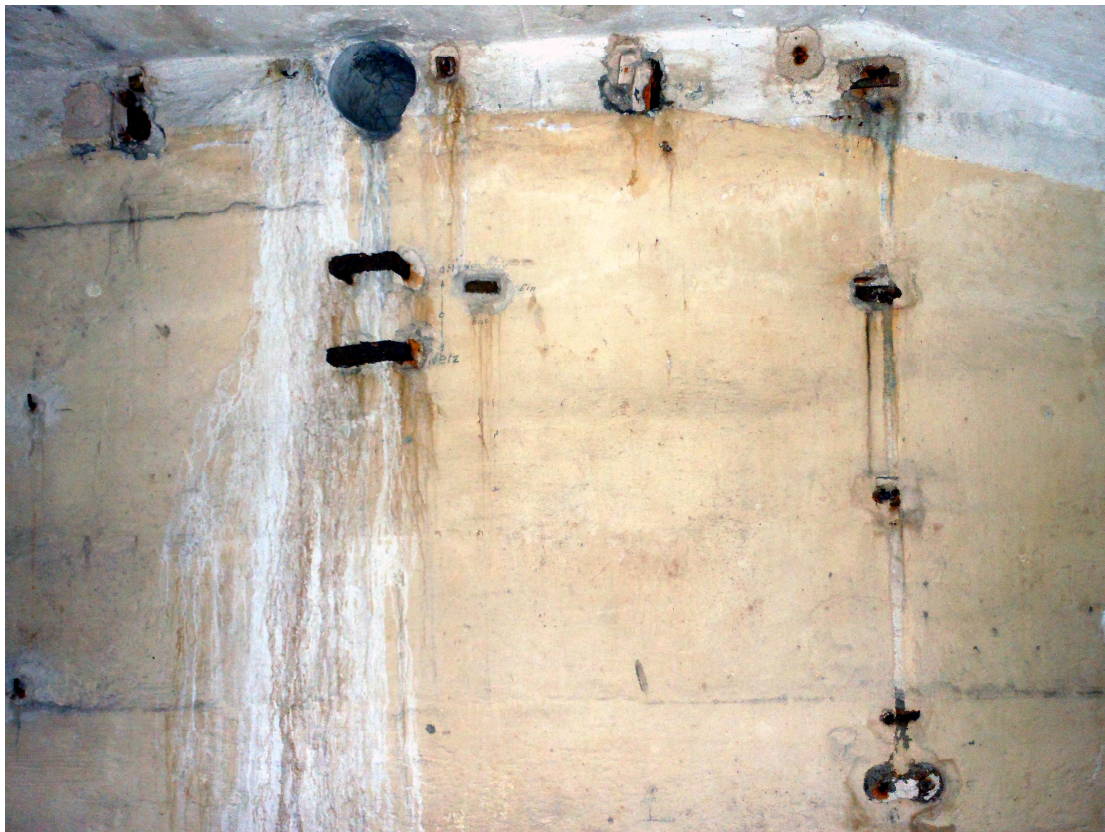
Fig. 30: vano 1 – dettaglio completo delle connessioni del quadro elettrico
