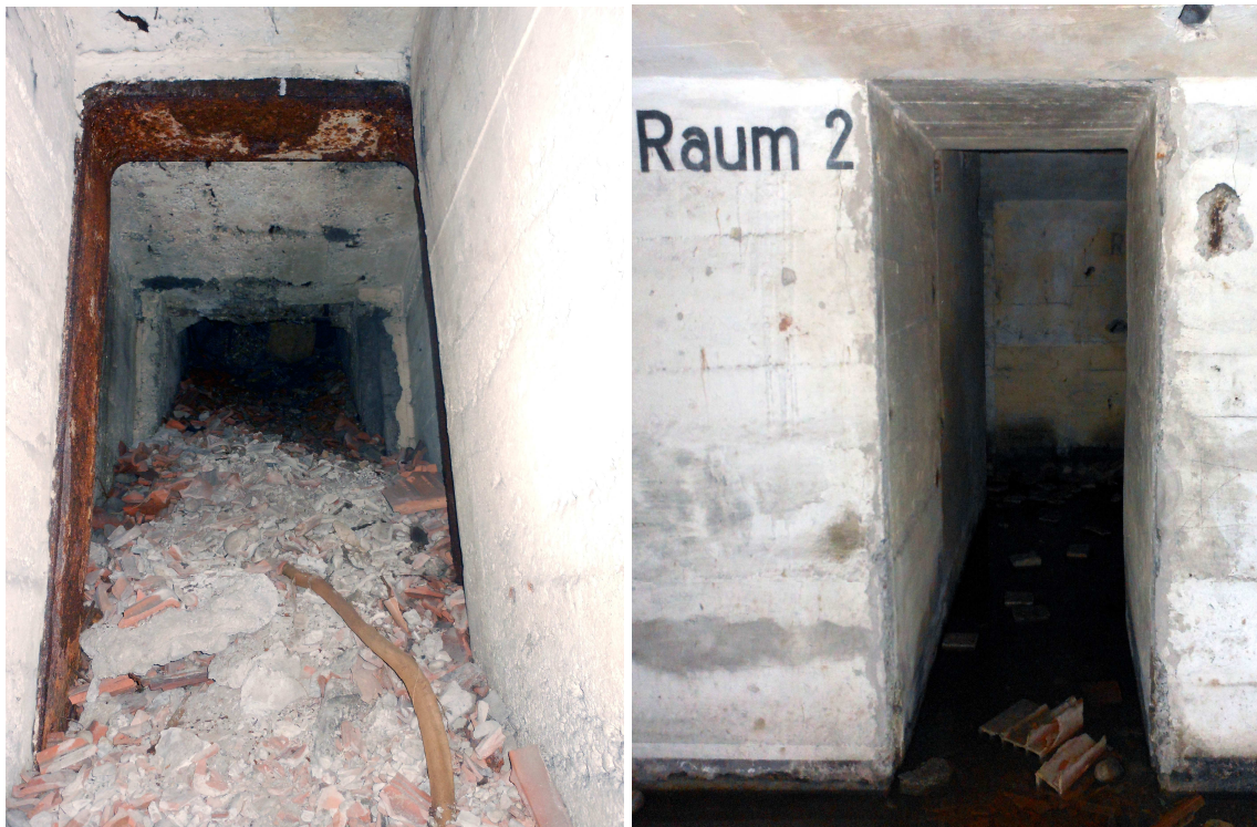
Fig. 24: vano 4, Raum 2 - ingresso / Fig. 25: vano 4, Raum 2 - ingresso al vano 3 uscita verso la stazione di Verona Porta Nuova– dettagli
