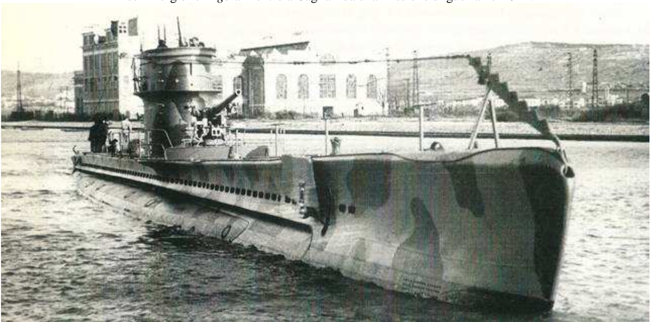
Bella immagine dell'Asteria, uno dei sommergibili italiani che forzarono la Baia di Bougie. Osservare l'affinamento dello scafo e la torretta costruita su modello di quelle degli U-boote.
