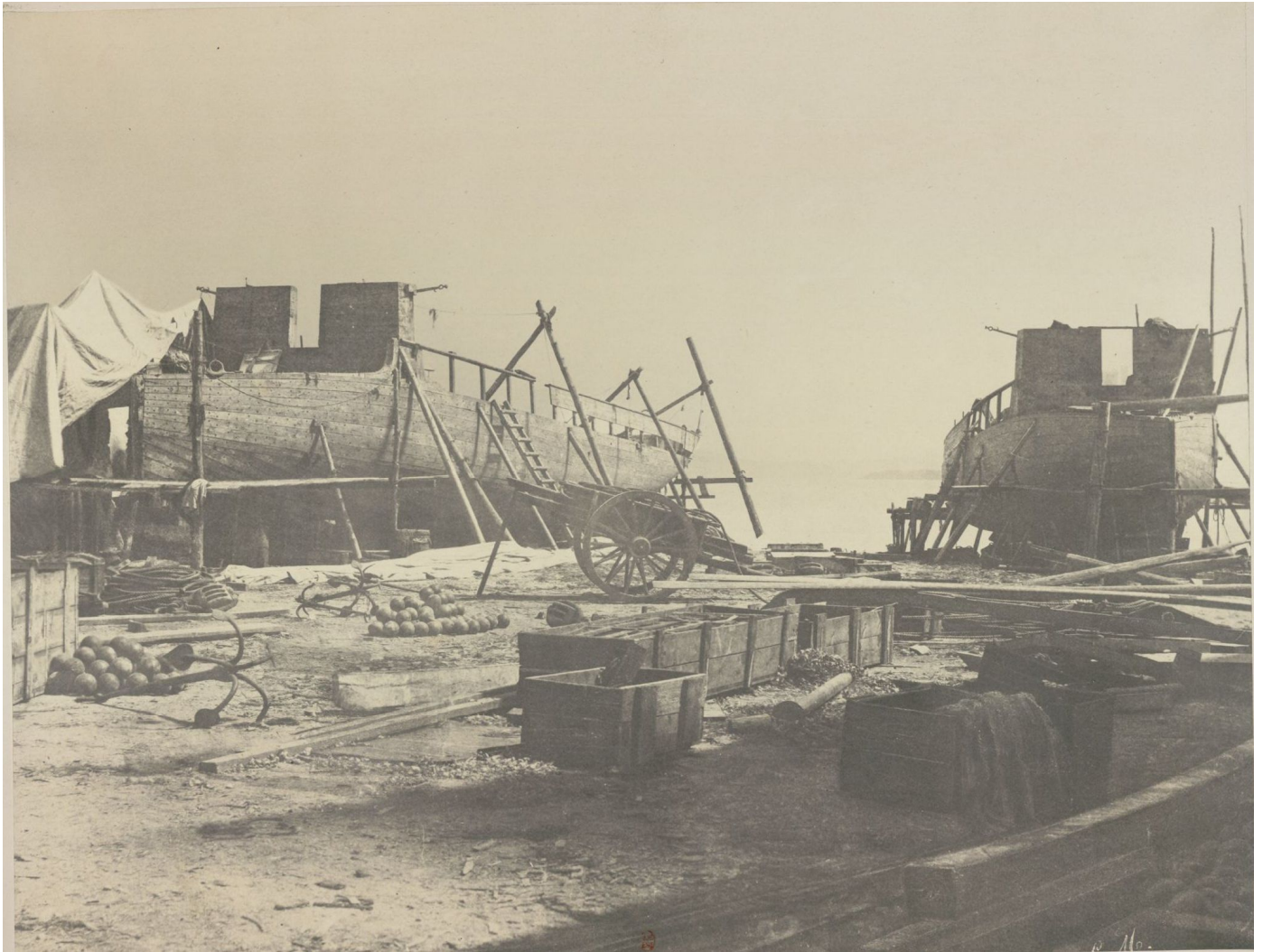
Fig. 8. Due delle cannoniere in fase di assemblaggio a Desenzano del Garda. Ben visibile è la feritoia verticale del cannone e l'inclinazione negativa del "castello di prua". E' possibile che le palle di cannone visibili sulla sinistra facessero parte della riserva di proiettili delle due unità. Foto di Léon Méhédin, Campagne d'Italie en 1859 . Bibliothèque Nationale de France, via sito web Gallica, collezione dell'autore.
