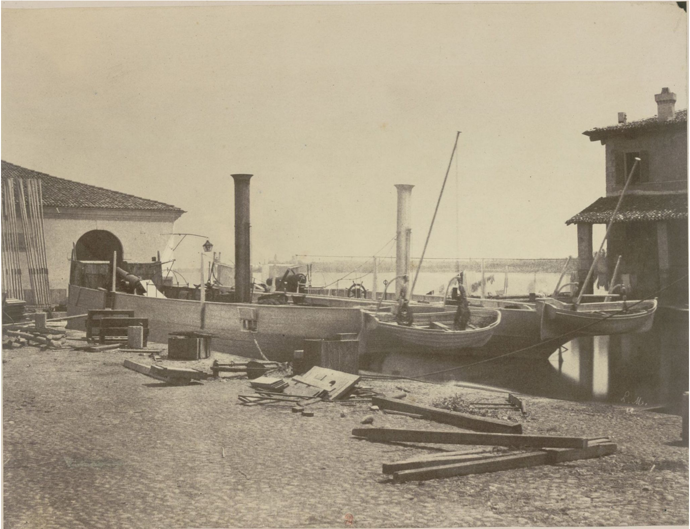
Fig. 9. Due cannoniere in acqua ad allestimento pressoché completo e con l'armamento installato. La ruota del timone appare collocata più a poppavia di quanto risulta dal progetto. Foto di Léon Méhédin, Campagne d'Italie en 1859 .
