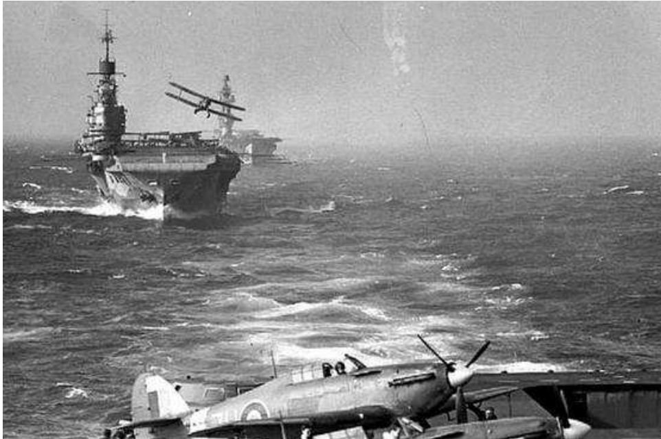
Sopra, l'immagine, ripresa dalla Victorious , mostra la Indomitable , la Eagle e un incrociatore classe "Dido" che procedono in linea di fila. Si nota sulla Indomitable la barriera che attraversa il ponte di volo e che serviva per frenare l'atterraggio degli aerei in condizioni di emergenza. Sotto, il decollo di un Albacore dalla Indomitable , sempre preceduta in formazione dalla Victorious e seguita dalla Eagle .
