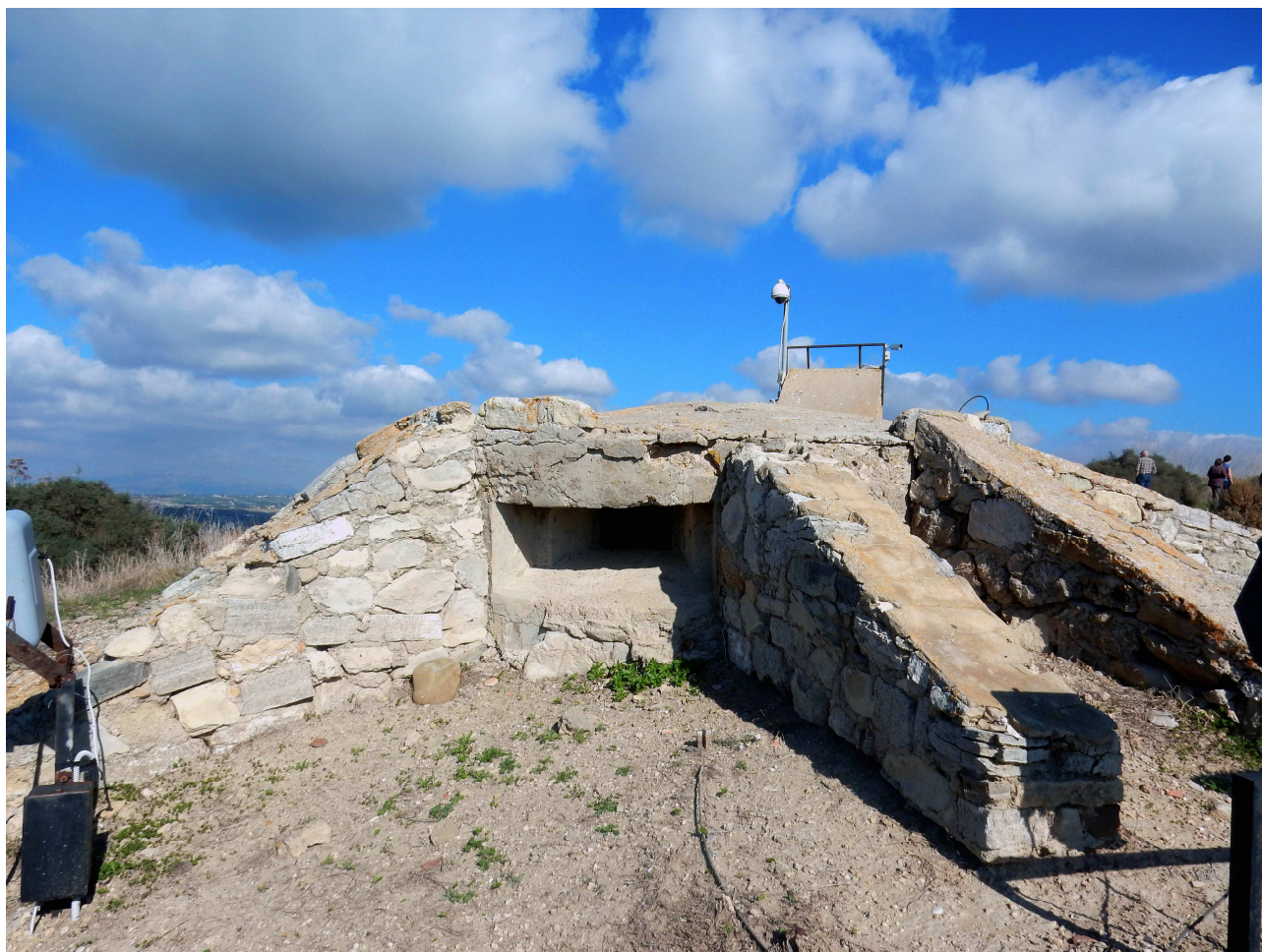
Fig. 6: feritoia centrale con muretti di protezione, in alto l'entrata inclinata del bunker
