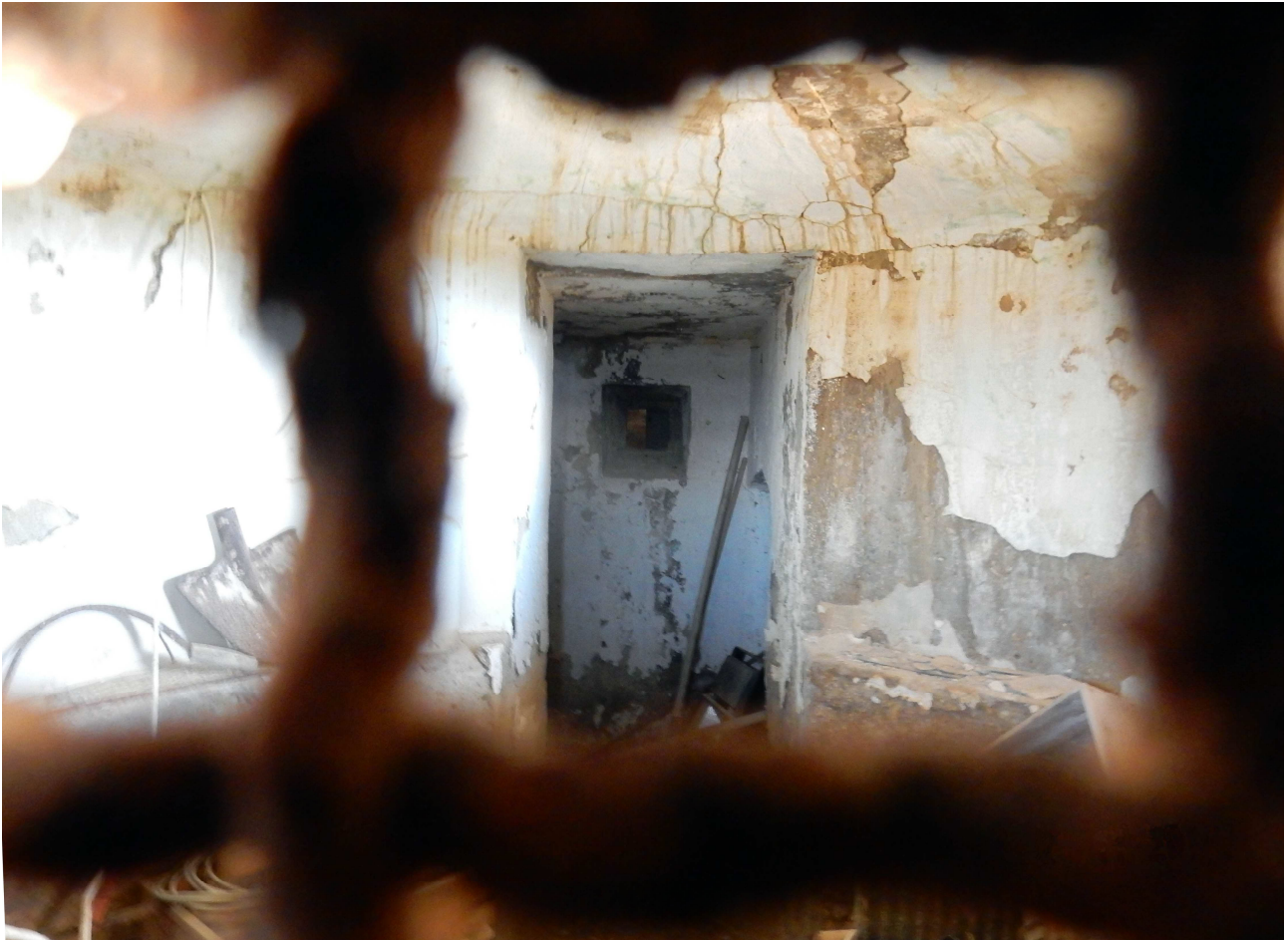
Fig. 7: visione dell'ingresso della camera di tiro con muro divisorio e feritoia quadrata per la difesa interna, in basso a sinistra ed a destra porzioni della mensola circolare di appoggio
