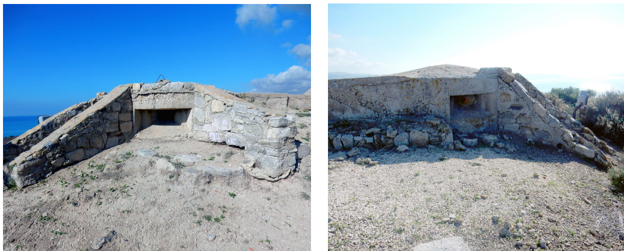
Fig. 5: feritoie rettangolari laterali della camera di tiro con muretti di protezione
