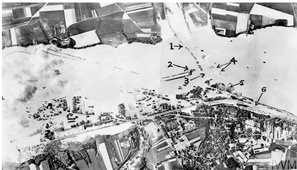
I danni causati dall'acqua uscita dalla diga di Mohne. Si notano una strada allagata (1), una centrale elettrica isolata (2), la distruzione di ponti stradali (3) e ferroviari (4), materiale rotabile distrutto (5) e tettoie sommerse (6). (Foto: IWM)
