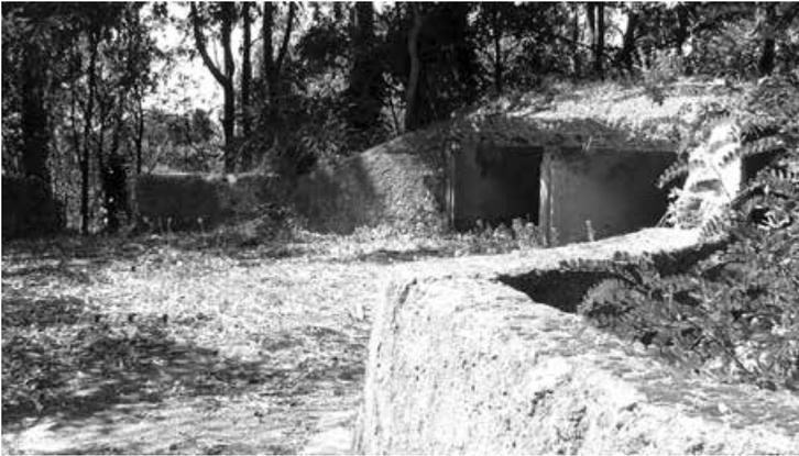
Messina. Una delle 4 piazzole della batteria a. a. MS 475, armata con pezzi da 76/40 sostituiti nel 1943 con 90/53. Si notano al centro i perni prigionieri per la piastra e i vani munizioni di pronto impiego. (A. Donato)
